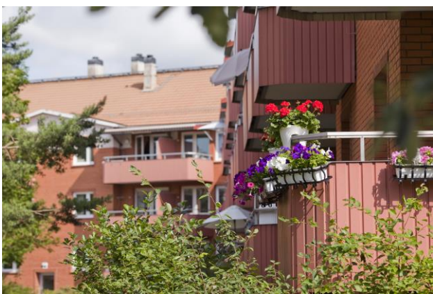
Rikshems fastighet Svärdslijan i Gideonsberg, Västerås. Den är byggd på 50-talet och renoverades under mitten av 80-talet. De 254 lägenheterna i området har alla balkong.
