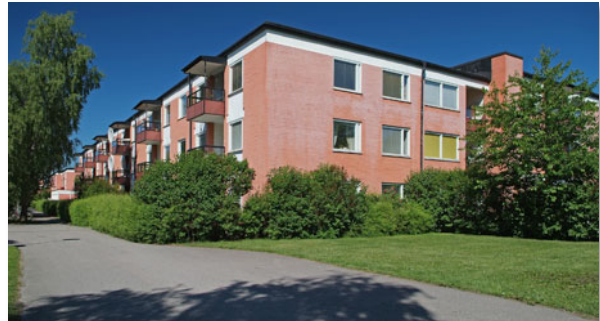
Ovan en fastighet i Gränby, Uppsala, vilken byggdes under 60-70-talet. Rikshem genomför en renovering av fastigheterna i området.
